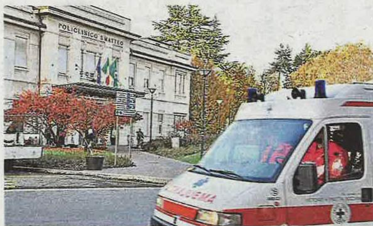
Una veduta dell'ingresso al Policlinico San Matteo di Pavia
